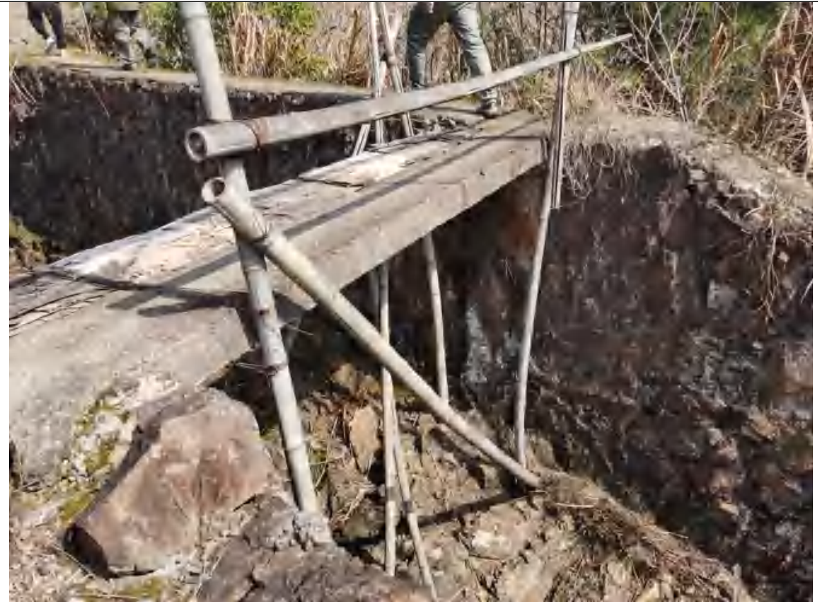
溢洪道上行通道
